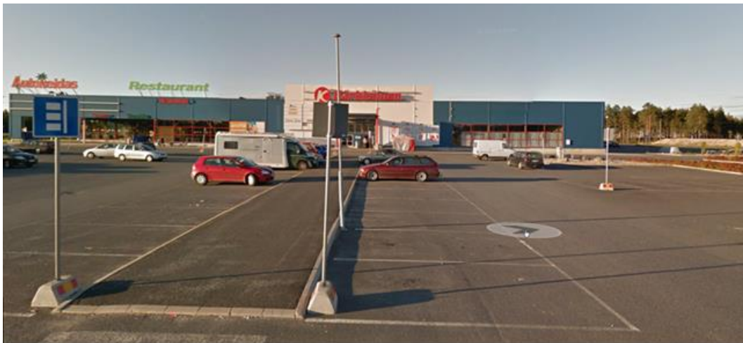
Kuva 7. Alueella sijaitsee Kärkkäisen tavaratalo pysäköintialueineen.
