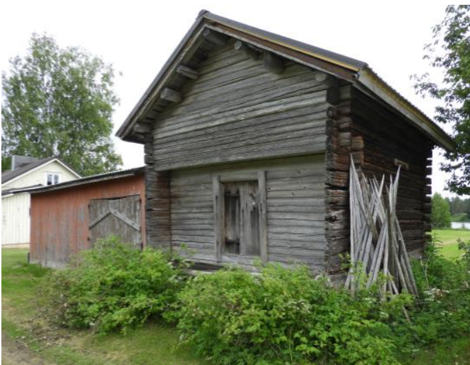
Kaksikerroksinen (4.) hirsiaitta ja vaja.
