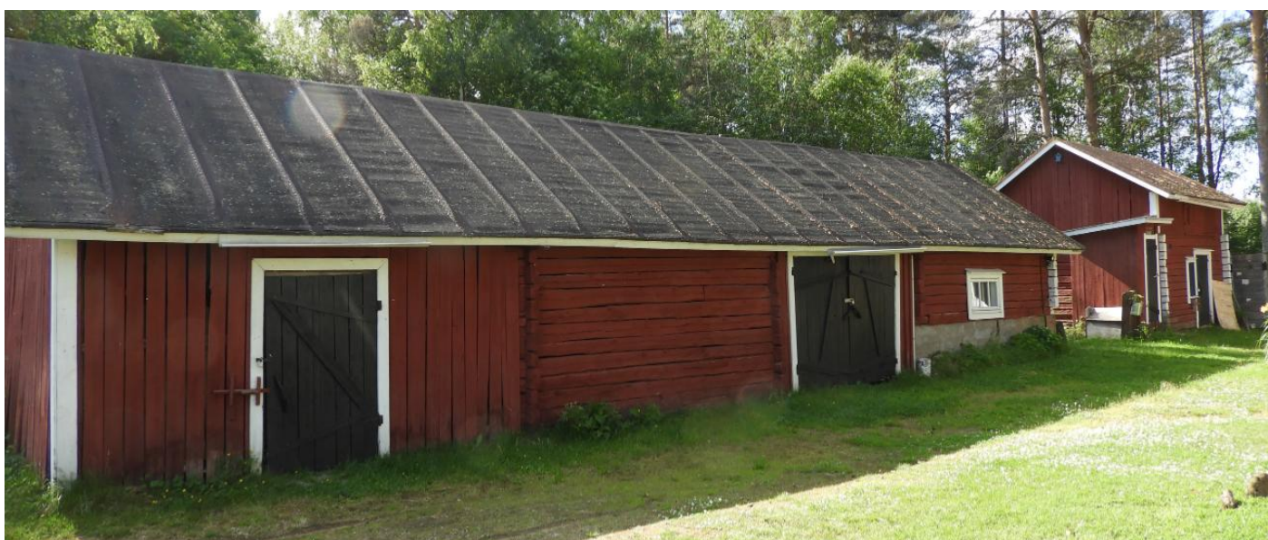
Kaivolan vanha navettarakennus (2.) ja taustalla näkyy aittarakennus.
