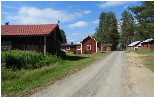
Näkymä Tuomaalanperäntieltä, vasemmalla Rähän vanhan päärakennuksen pihapiiri, oikealla aittoja ja latoja.
