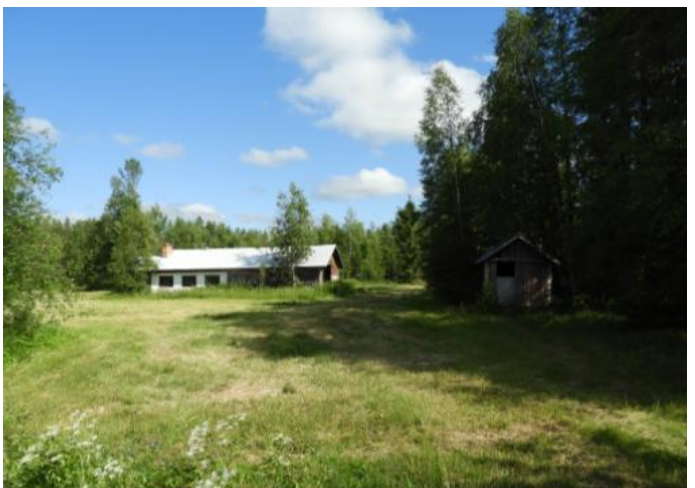
Jussilan (4.) päärakennus on purettu, jäljellä navetta ja vaja.
