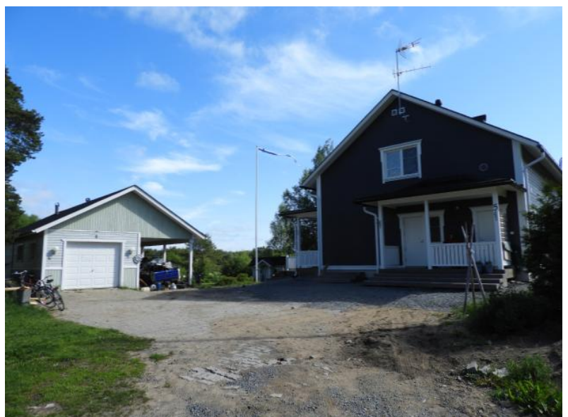
Kuopion vanhan päärakennuksen paikalle rakennettu uusi omakotitalo (4.).
