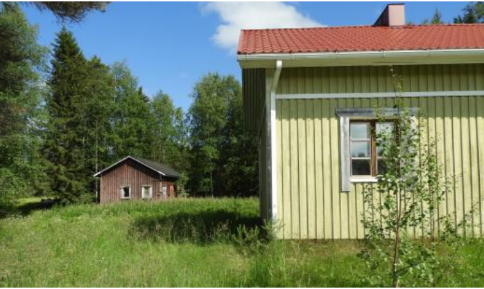
5. 60-luvulla rakennettu omakotitalo ja sen piharakennus.
