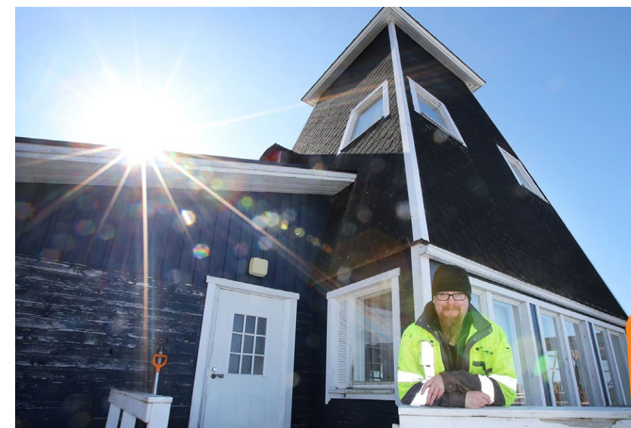
Ennen Vatungin Suvirannan ravintolan avajaisia, yrittäjä Teppo Tuovila on tehnyt mittavan remontin aiemmin Vatungin Pookina tunnettuun kiinteistöön.
