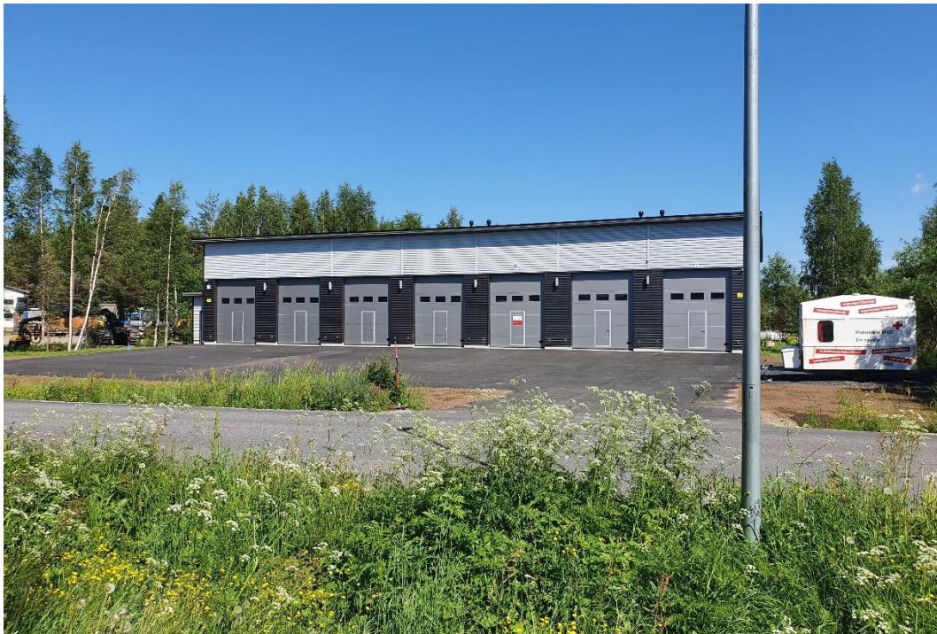
Kuva 2. Suunnittelualueen läntisen osa-alueen välittömään läheisyyteen sijoittuvaa varastorakentamista. Vastaavanlaista rakentamista on suunnitteilla myös asemakaavan muutosalueelle.
