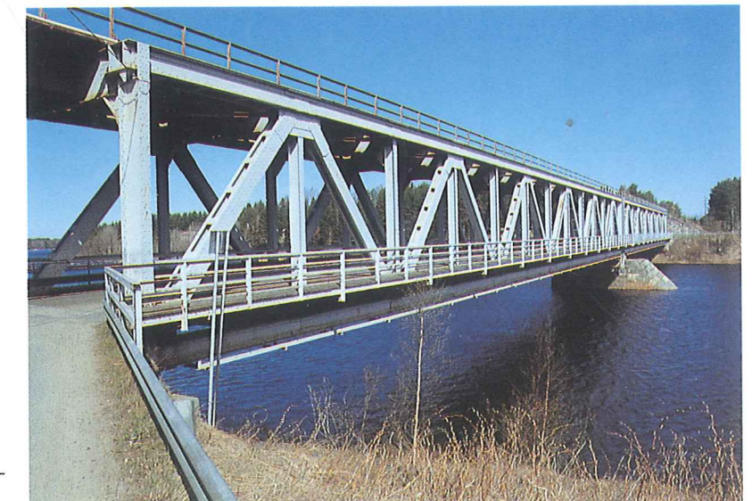
Asemankylän kaksikerroksinen rautatie- ja maantiesilta
