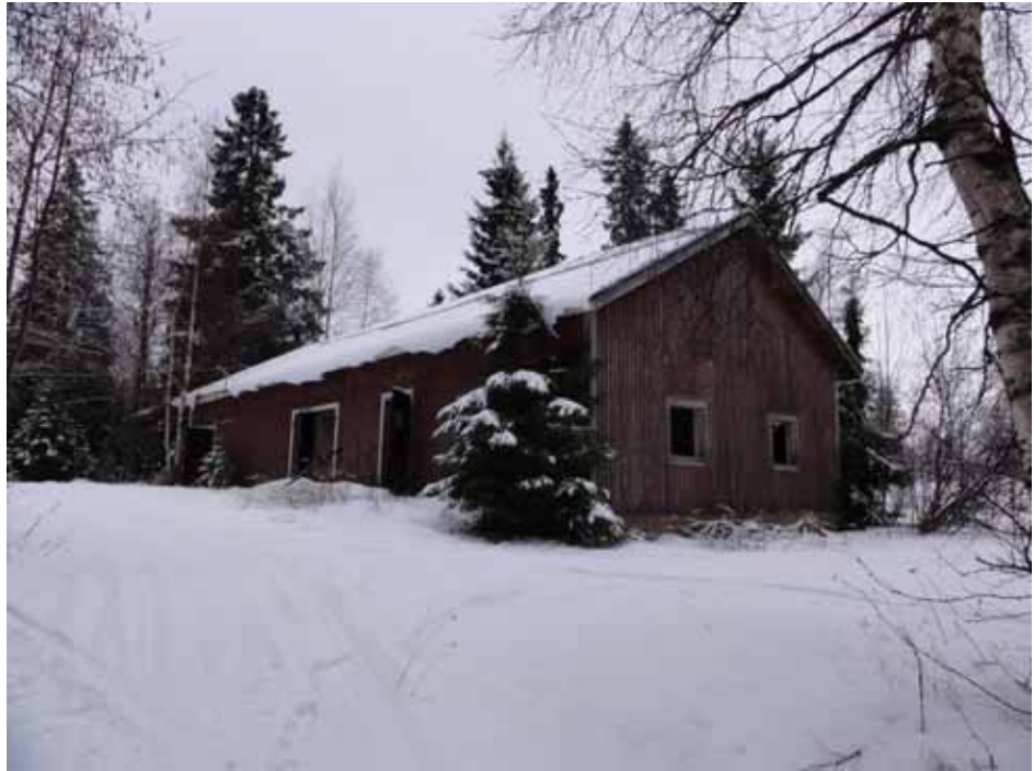
Kuva 18. Alarannantien päässä olevan veneenlaskupaikan yhteydessä oleva vaja.
