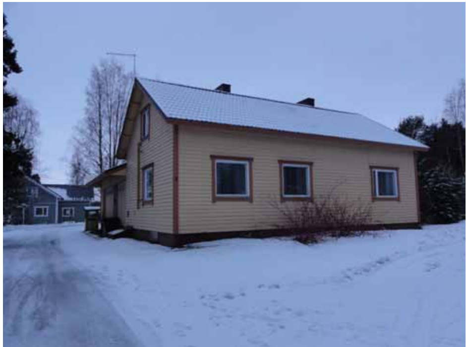
Kuva 21. Takalon tilakeskukselle vievän kulkutien porttia vahtii tämä asuinrakennus.
