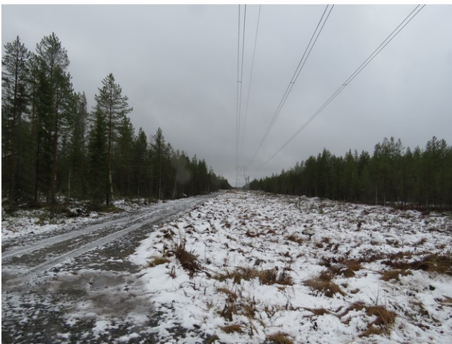
Kuva 1. Voimalinjan käytävä alueen lounaislaidalla. Tasainen sora-alue, kuvattu etelään.
