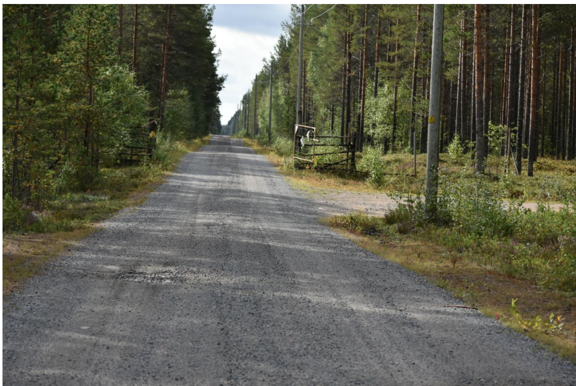
Kuva 38. Tiironkankaantie on hyväkuntoinen ja kantava tie, eikä edellytä merkittäviä vahvistustoimenpiteitä.
