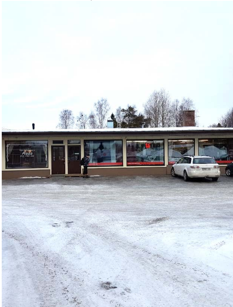
Ns. SPR:n talo haluttaisiin purkaa
