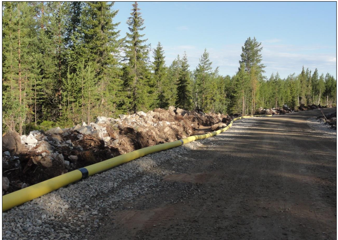
Kuva 21. Esimerkki tuulivoimapuiston rakennus- ja huoltotiestä. Teitä käytetään muun muassa betonin ja soran sekä voimaloiden komponenttien kuljetuksiin. Tuulivoimapuiston käyttövaiheessa teitä käytetään mm. vuosittaisissa huolloissa. Maakaapeli sijoitetaan ojakaivantomon tien reuna-alueelle (Kuva: Ville Suorsa / FCG).
