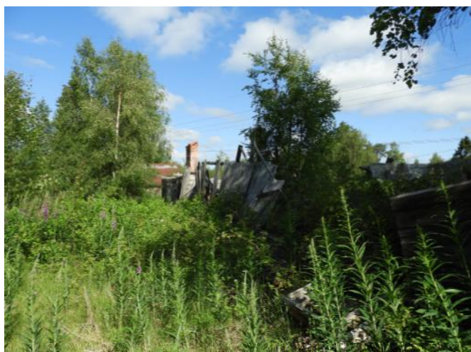
Mäkipaason lahonneita rakennuksia.
