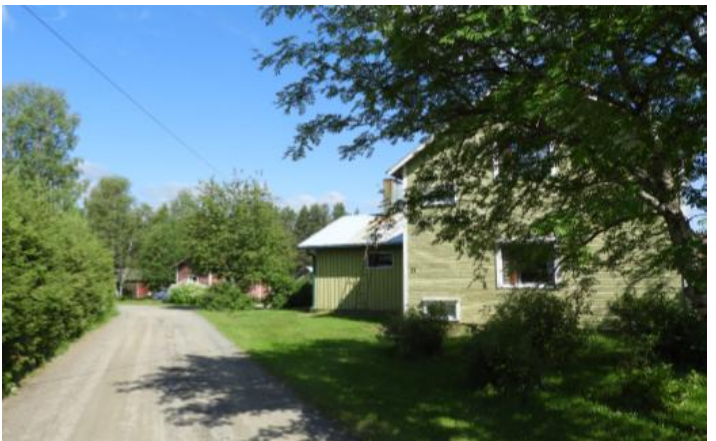
Kangastalon päärakennus 40-luvulta vanhan rakennuksen paikalla.
