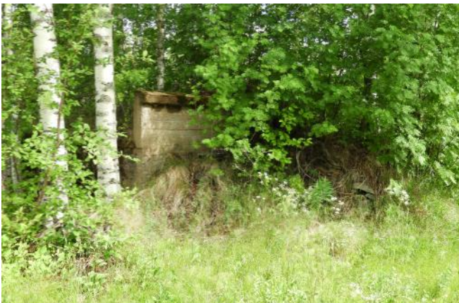
Puretun rakennuksen (2.) jäljellä oleva osa perustuksesta.
