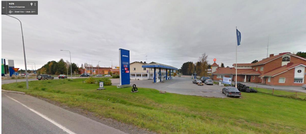
Kuva 6. Näkymä Valtatien varrelta lin keskustan suuntaan ennen kiertoliittymää. (Google Street View. Haettu 15.5.2017)
