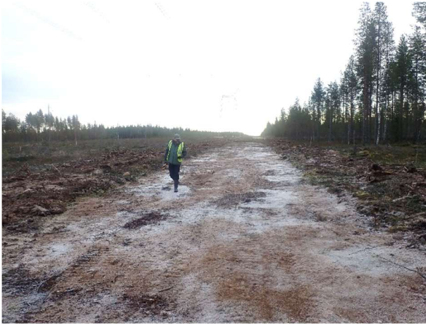
Kuva 5. Sähkölínjan aukkoa alueen laidalla. Taneli Leinonen tarkastelee ajouraa. Kuva: Arttu Tokoi.
