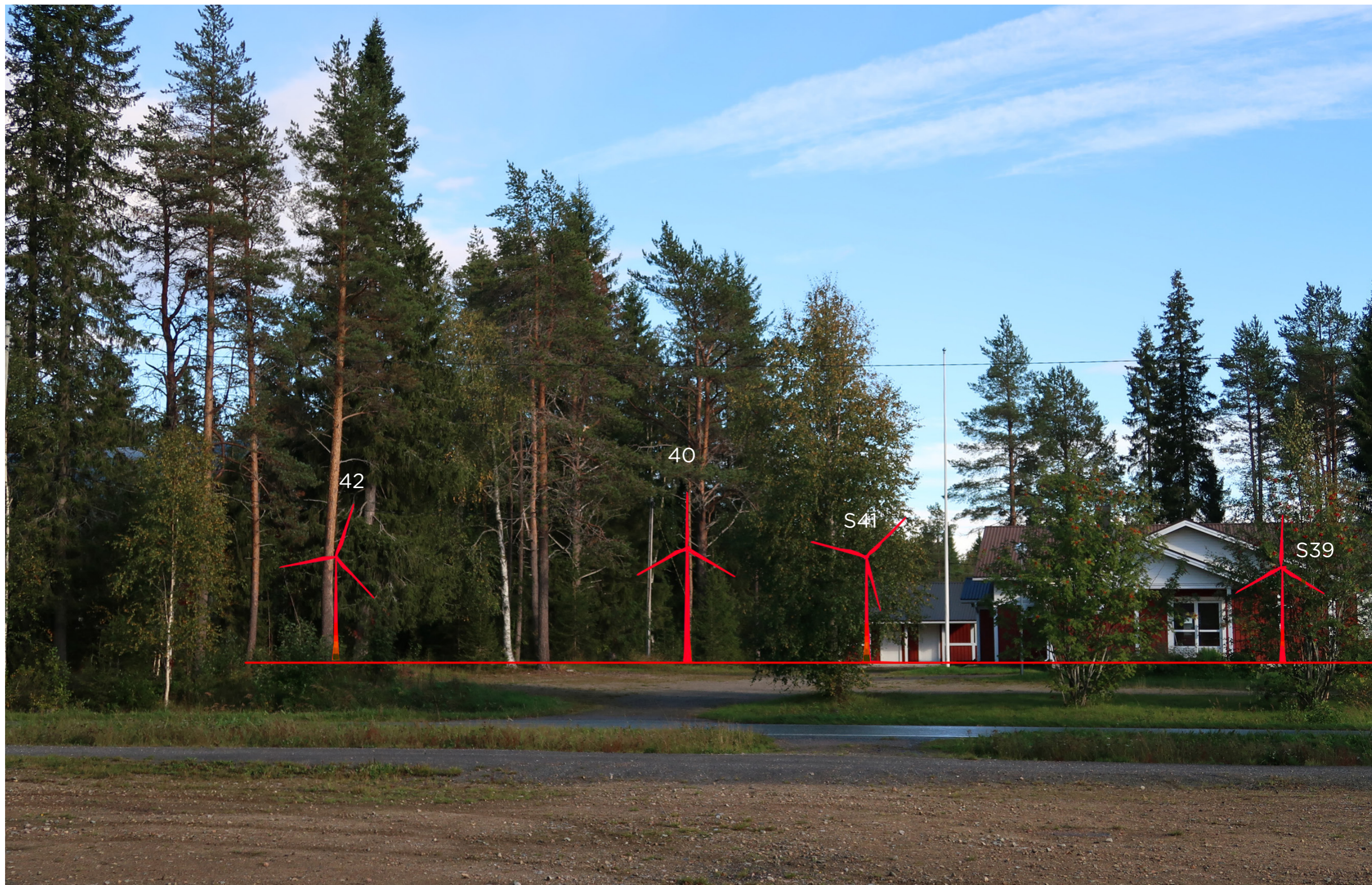
Kuvauspiste 4. Näkymä Hyryn koulun pihalta kohti Yli-Olhavan tuulivoimapuistoa. Maanpinta ja arvioitavat tuulivoimalat on esitetty punaisella korostevärillä. Kuvan voimalanumerot vastaavat mallinnuskarttojen voimalanumerointia. Etäisyys lähimpään arvioitavaan voimalaan on 2,8 km.
