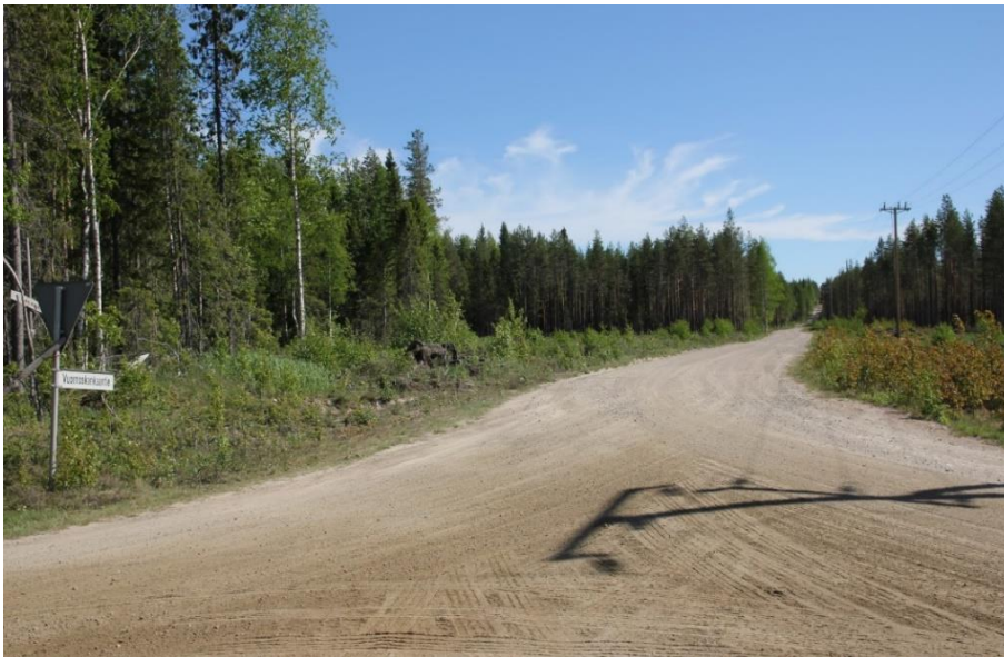
Kuva 125. Vuornoskankaantien ja Konttilantien risteys.
