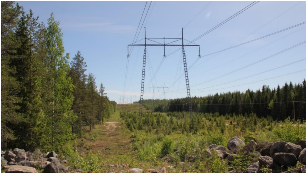
Kuva 135. Johtoaukea hankealueen pohjoisosassa Konttilanperällä, kuvauskulma pohjoisesta etelään. Kuvassa Fingridin kaksi 400 kV:n voimajohtoa sekä vasemmassa reunassa moottorikelkkaura. Ollinkorven suunniteltu sähkönsiirtoreitti sijoittuisi johtokäytävän itäpuolelle, kuvassa vasemmalle puolelle.
