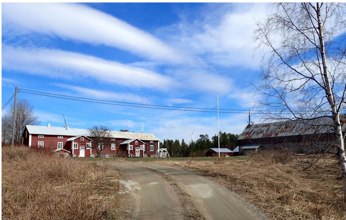
Kuva 8. Nybyn päärakennus ja kivinavetta (Pohjanmaan teollisuuden kartanot).
