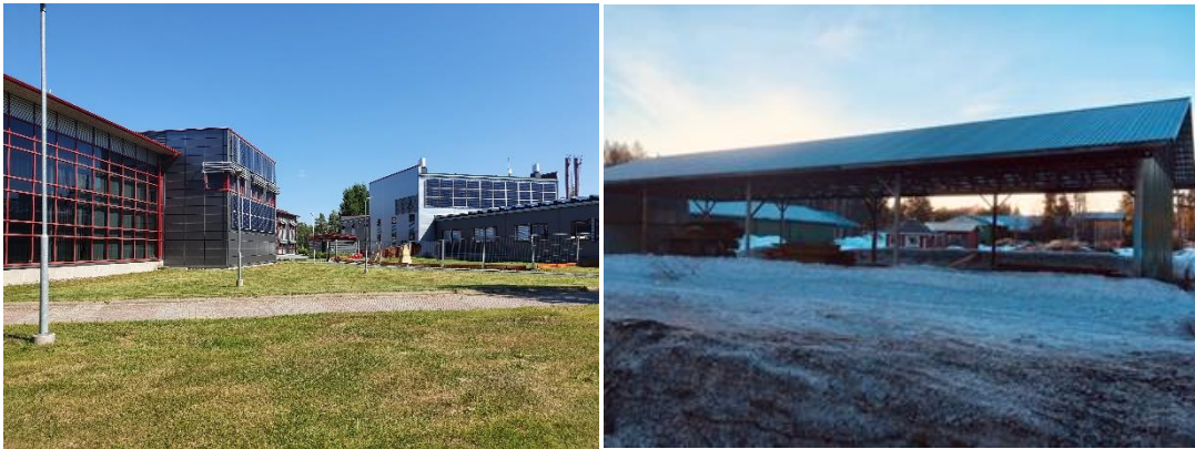
Kuva 14 ja 15. Suunnittelualueella sijaitsee arkkitehtuuriltaan laadukas teknologiakeskus Micropolis (vas). Itäosassa sijaitsee vanhoja alueella sijainneeseen teollisuustoimintaan liittyviä rakenteita.
