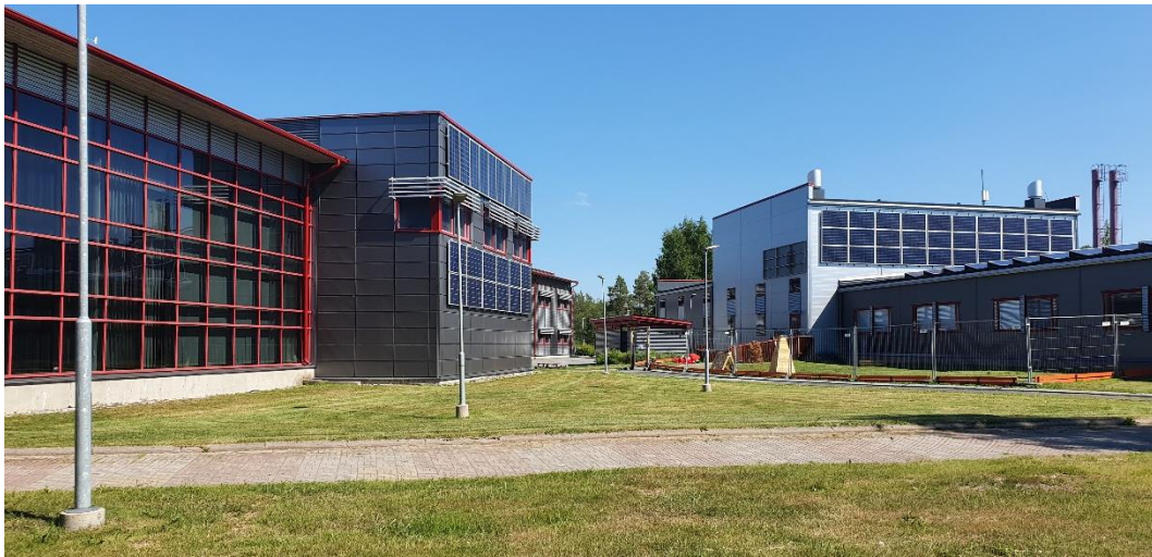
Kuva 5. Suunnittelualueella sijaitse arkkitehtuuriltaan laadukas teknologiakeskus Micropolis.
