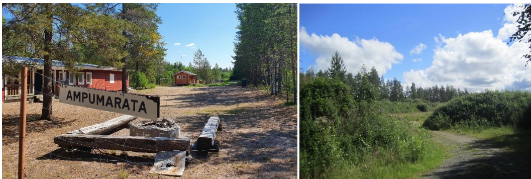
Kuvat 28 ja 29. Ampumarata-alueen rakennuskantaa ja ampumaradan valleja.
