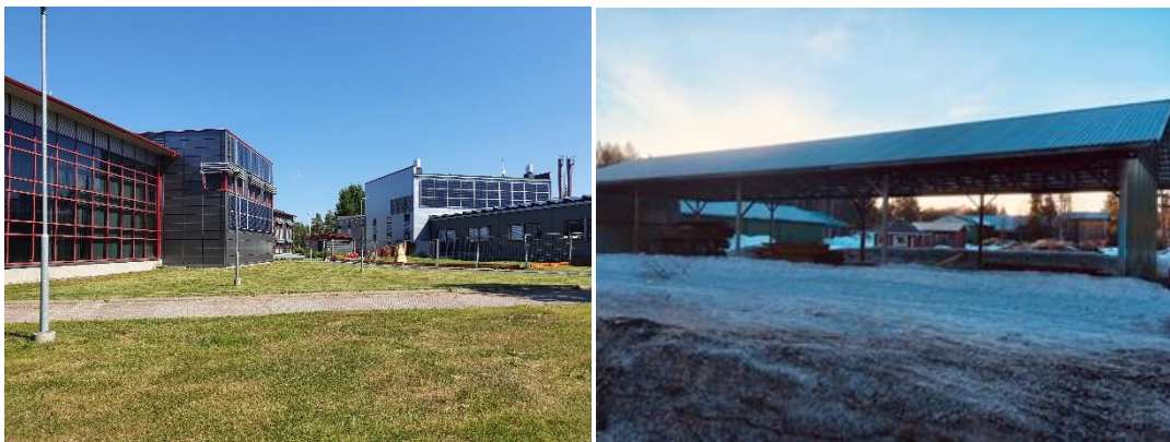
Kuva 14 ja 15. Suunnittelualueella sijaitsee arkkitehtuuriltaan laadukas teknologiakeskus Micropolis (vas). Itäosassa sijaitsee vanhoja alueella sijainneeseen teollisuustoimintaan liittyviä rakenteita.
