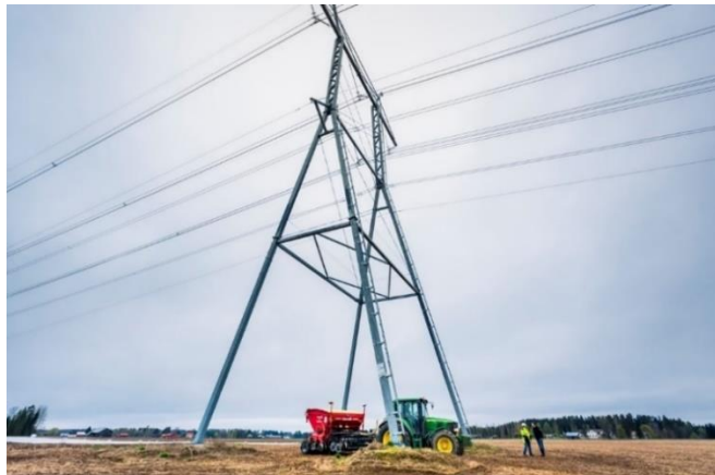
Kuva 16. Peltopylväs (Fingrid Oyj).
