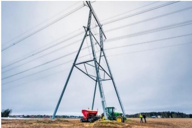
Kuva 16. Peltopylväs (Fingrid Oyj).
