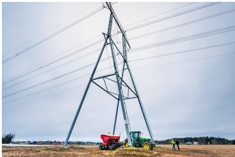
Kuva 17. Peltopylväs (Fingrid Oyj).
